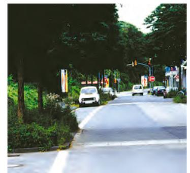
Bild 14: Teilaufpflasterung in Asphalt mit S-förmigen Rampensteinen
